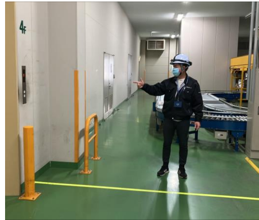
②倉庫内の確認(被災状況)
